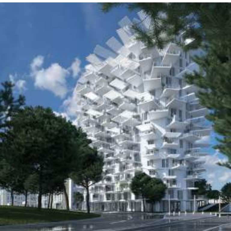
Chantier : l'Arbre Blanc - Montpellier
